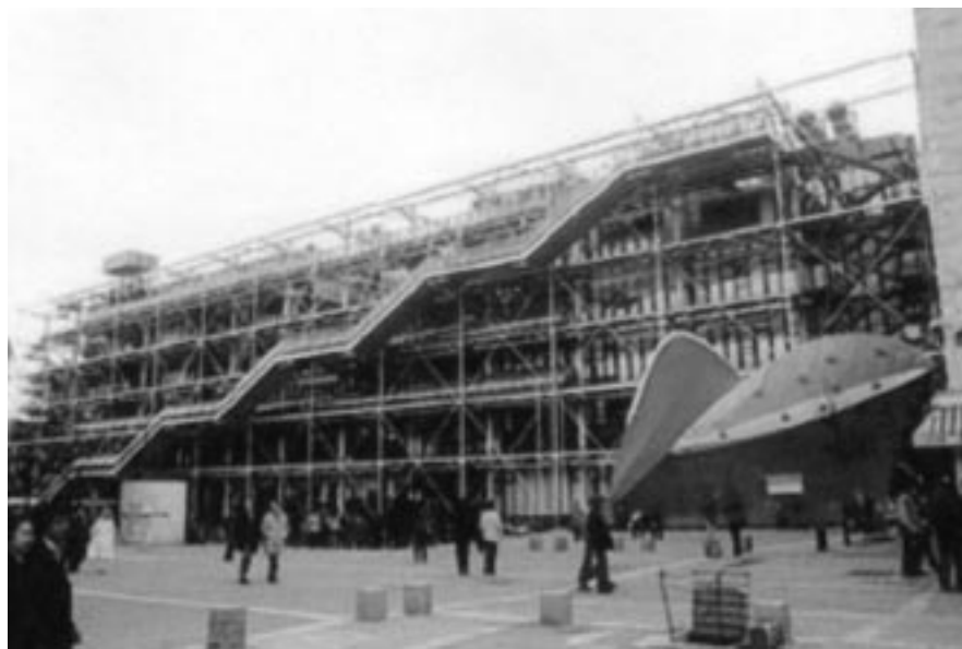
واجهة مركز بومبيدو بمكوناتها الحديدية ودرجها الآلي
